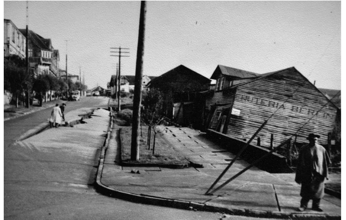
Grieta en la cuesta Del Salvador.
